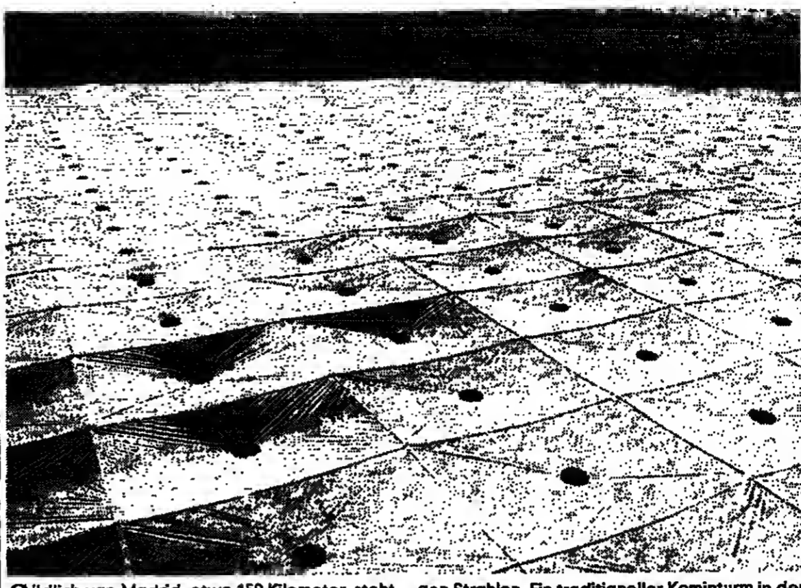
Südlich von Madrid, etwa 150 Kilometer, steht das erste Aufwindkraftwerk der Welt. Die Folie läßt die kurzwelligen Strahlen durch, isoliert aber gegenüber den erwärmten langwelligen Strahlen. Ein traditioneller Kominturm in der Mitte der Anlage saugt die erwärmte Luft an und treibt über eine Turbine einen Generator.
